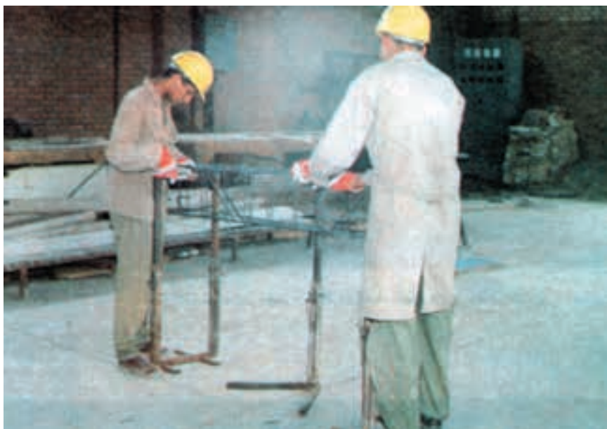
شکل ۱۲-۳- طریقه‌ی مونتاژ آرماتورهای یک پوتر کوچک
