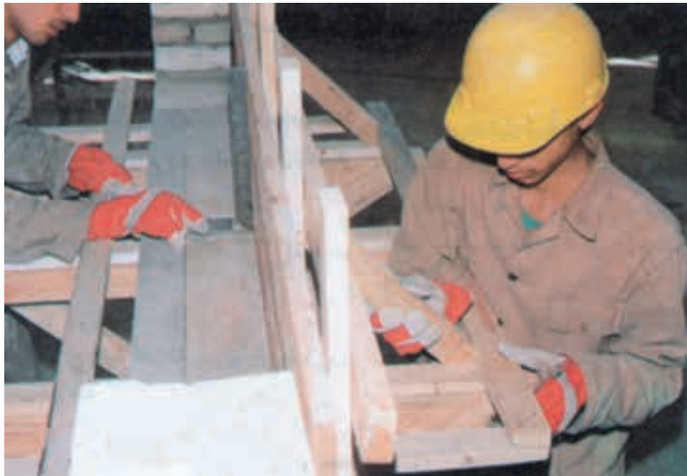
شکل ۱۱-۳- نصب گونه، گونیاکردن و نصب دستک‌ها
