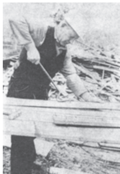
شکل ۱-۳۰ - میخ‌کشی از تخته توسط میخ‌کش اهرمی
